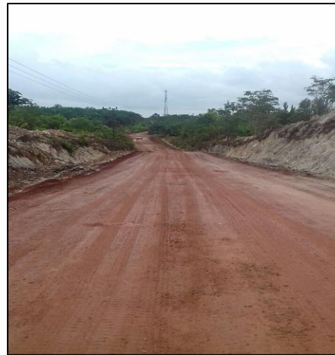
Kondisi Sta.48+300 (Sudah Perbaikan)
