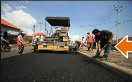
Pembangunan jalan aspal karet
